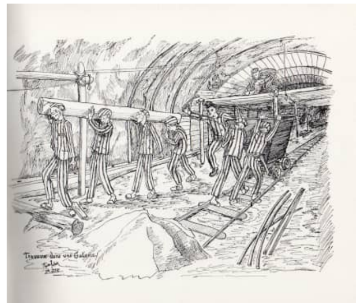
Un dessin que Daniel Piquée-Audrain légendé ainsi : Travaux dans une galerie, Melk Mauthausen
